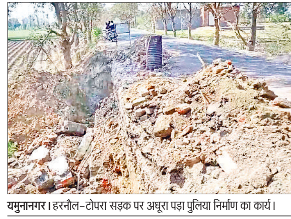
यमुनानगर। हरनौल-टोपरा सड़क पर अधूरा पड़ा पुलिया निर्माण का कार्य।
